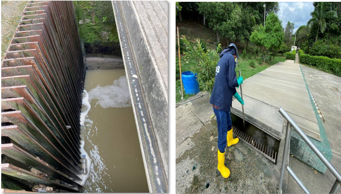
Ilustración 2 Rejilla gruesa, limpieza manual
