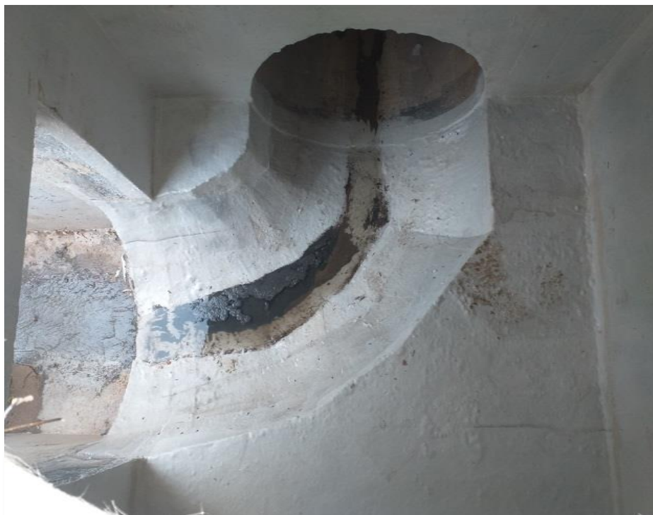
Ilustración 13 Detalle de la estructura en concreto
