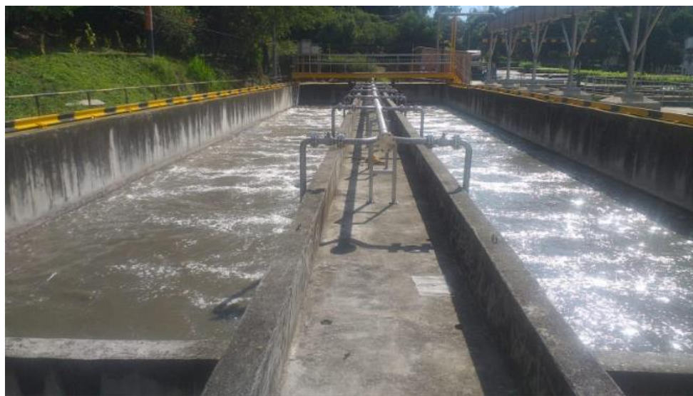
Ilustración 10 Obras eléctricas, mecánicas y civiles para la puesta en operación del desarenador aireado con capacidad de 1500 L/S
