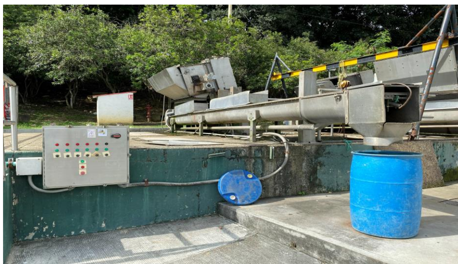
Ilustración 3 Rejilla automática y extracción de residuos
