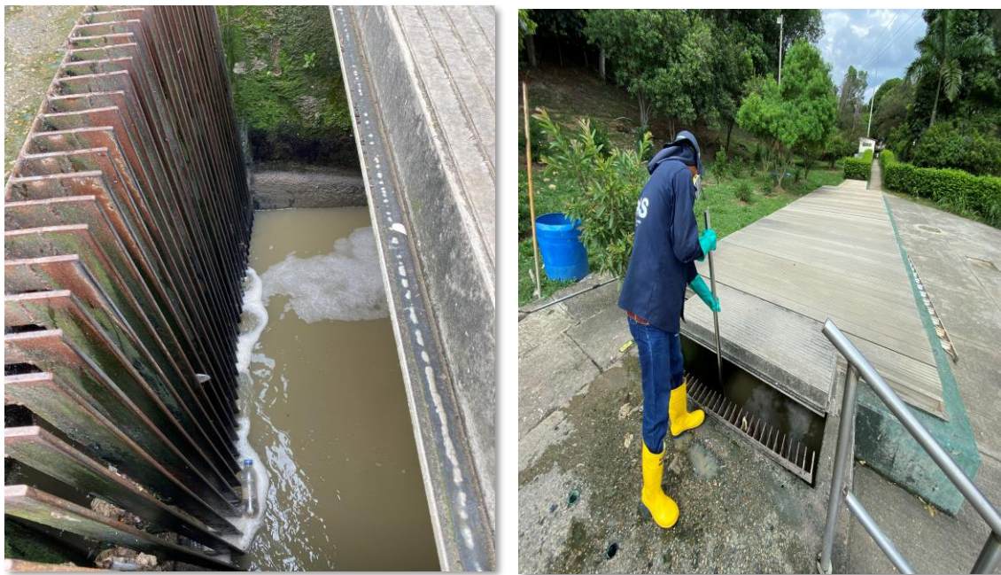
Ilustración 2 Rejilla gruesa, limpieza manual
