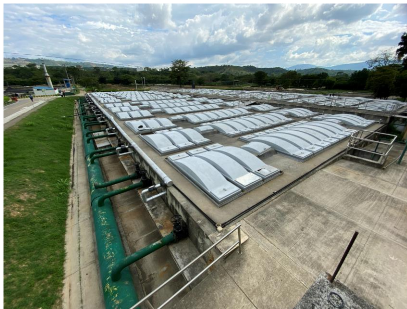
Ilustración 6 Reactor UASB No. 5
