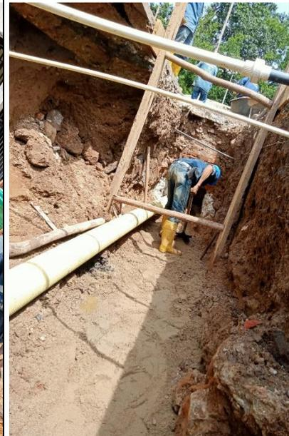
OBRA DE REPOSICION DEL COLECTOR PLUVIAL EN EL BARRIO FÁTIMA (MANZANA B - CASA 18B)
