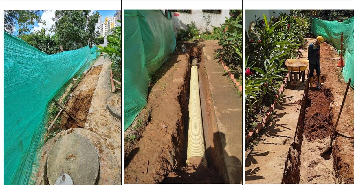
OBRA DE REPOSICION DEL COLECTOR COMBINADO EN EL BARRIO CALDAS (CALLE 106 -106A - CRA 34)
