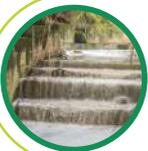
**Canal:** Es una estructura construida en concreto o gaviones, usada para encauzar las aguas y conducir las hacia las fuentes hídricas y evitar que éstas se desborden y ocasionen daños.
