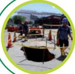
**Apique:** Excavación que se hace en la superficie de la vía para verificar posibles daños en las redes de alcantarillado.
