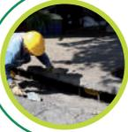
**Sumidero Lateral:** Estructura en concreto construida sobre el eje longitudinal de la vía en el andén y es empleado para recoger las aguas lluvias y conducir las al sistema de alcantarillado.
