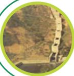
**Estructura de vertimiento:** Esta estructura está diseñada para conducir las aguas servidas a su destino final. De igual forma previene y evita la erosión en las escarpas.
