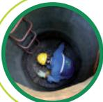
**Cámara de caída:** Estructura de concreto localizada en el pozo para minimizar el golpe de caída de las aguas.
