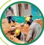
**Conexión domiciliaria:** La acometida de alcantarillado sanitaria o pluvial, es la red que conduce las aguas desde la caja de inspección de la vivienda hasta la red principal o red matriz.
