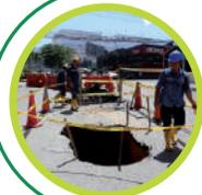
**Apique:** Excavación que se hace en la superficie de la vía para verificar posibles daños en las redes de alcantarillado.
