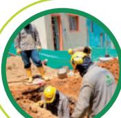
**Conexión domiciliaria:** La acometida de alcantarillado sanitaria o pluvial, es la red que conduce las aguas desde la caja de inspección de la vivienda hasta la red principal o red matriz.
