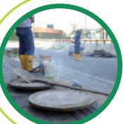
**Tapa núcleo:** Implemento Usado para cerrar o tapan el pozo de inspección y para permitir el flujo vehicular.
