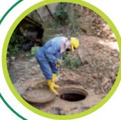
**Pozo de inspección:** Estructura en concreto y ladrillo destinado a recibir las aguas servidas. Se utiliza para ejercer limpieza y mantenimiento en las redes sanitarias y pluviales.
