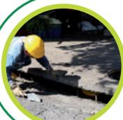
**Sumidero Lateral:** Estructura en concreto construida sobre el eje longitudinal de la vía en el andén y es empleado para recoger las aguas lluvias y conducir las al sistema de alcantarillado.
