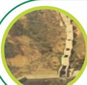
**Estructura de vertimiento:** Esta estructura está diseñada para conducir las aguas servidas a su destino final. De igual forma previene y evita la erosión en las escarpas.
