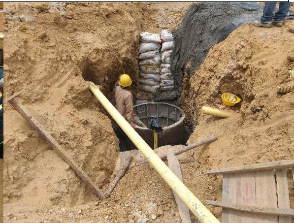
Fundida de cilindro en concreto de 3000psi en el pozo de inspección P(PV)L5
