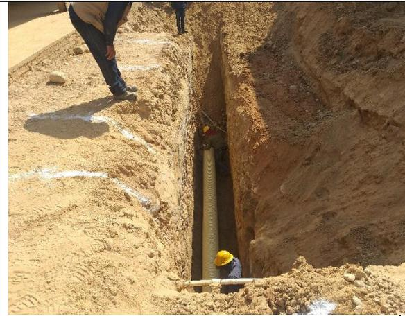
Instalación de tubería de 355mm en el tramo P(PV)L5 P(PV)L4
