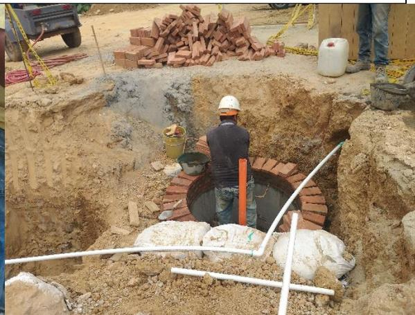
Construcción de cilindro en mampostería en el pozo de inspección P(PV)L2
