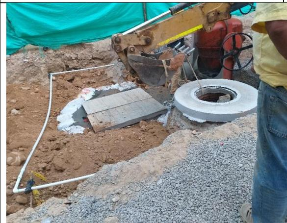
Instalación de corona en concreto en el pozo de inspección P(PV)L4
