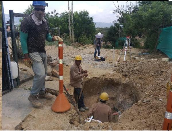
Excavación manual para construcción pozo de inspección P(PV)L11
