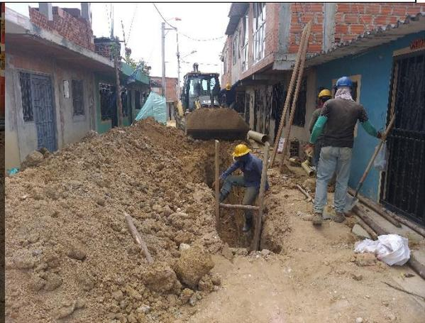
Replanteo instalación de arena para cimentación en el tramo P(PV)L11-P(PV)L2
