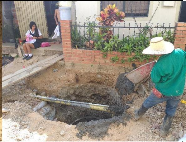
Fundida de cilindro en concreto de 3000psi en el pozo de inspección P(PV)L16
