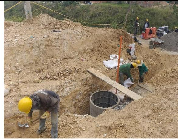
Fundida de cilindro en concreto de 3000psi en el pozo de inspección P(PV)L6
