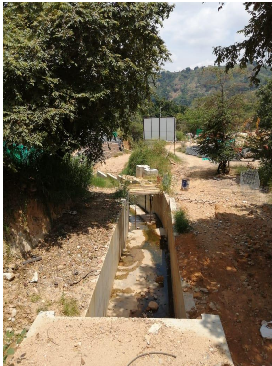
Vista general del canal y ubicación de paso peatonal
