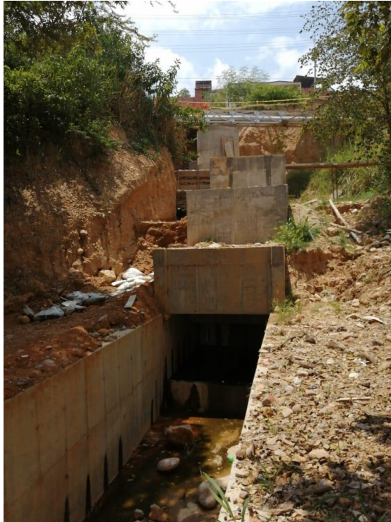
Parte alta del canal – disipadores de energía
