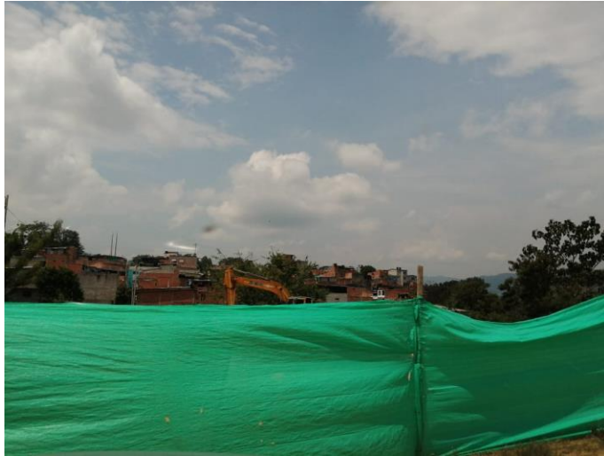
Aspecto general del cerramiento de la obra
