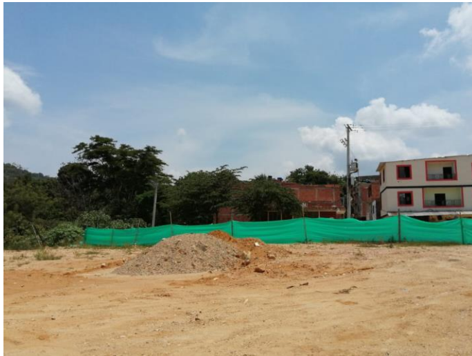
Aspecto general del cerramiento de la obra
