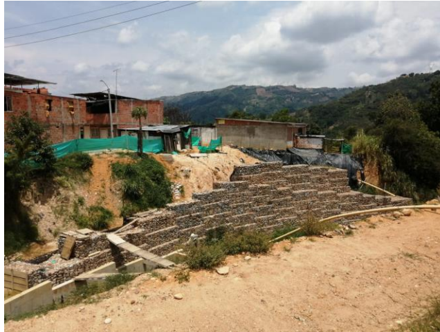
Muro de contención en gaviones
