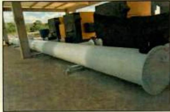
Acabado y pintura recirculación de lodos y Conducción de aire
