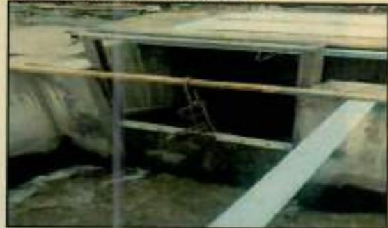
Se instaló una compuerta en el cribado con el fin de desviar caudal hacia el desarenador 2 y el Reactor UABS 5, obra que hace parte del proyecto de ampliación de la planta.
