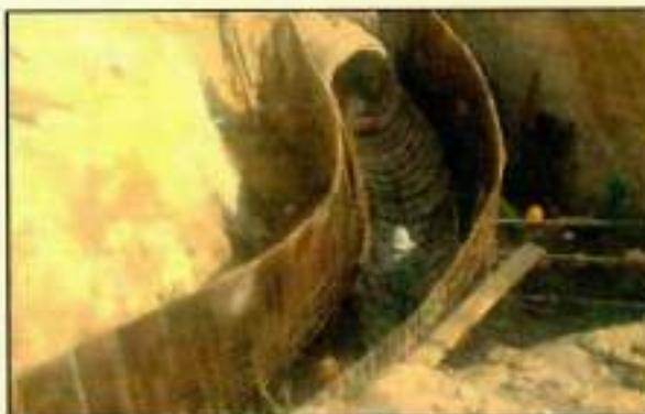
Encamado, acostillado y relleno inicial de la tubería en arena
