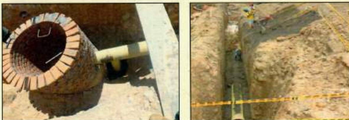
Instalación de tuberías y construcción de pozos de inspección. Fuente: EMPAS S.A
