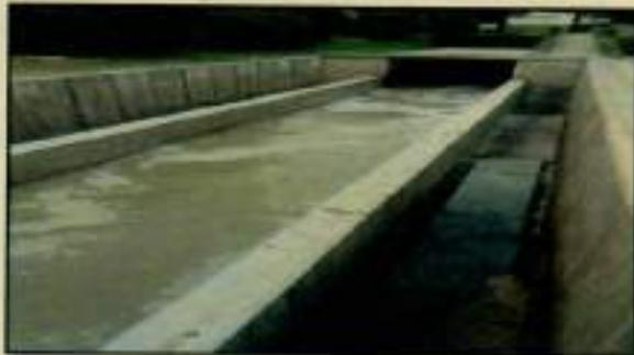
Se realizaron los muros del canal de entrada con el fin de garantizar el ingreso de la totalidad del caudal afluente a la planta y su tratamiento.
