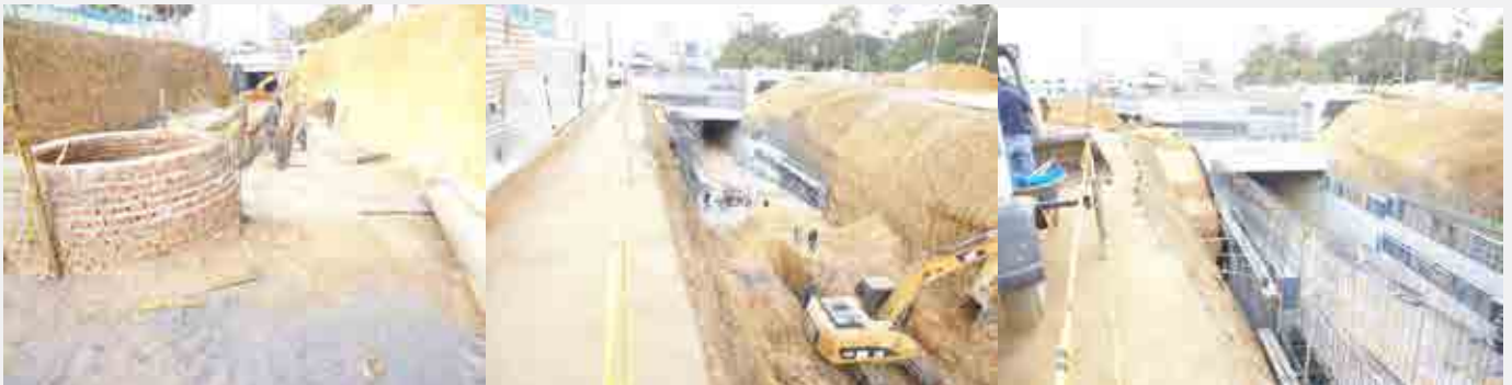
Instalación de tubería y elaboración de pozos de inspección en diámetro 1.8mts
