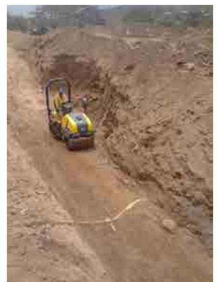
Conformación y compactación de rellenos
