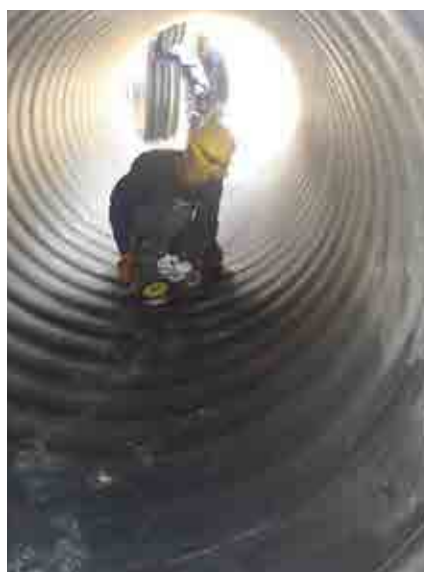
Instalación de Tubería
