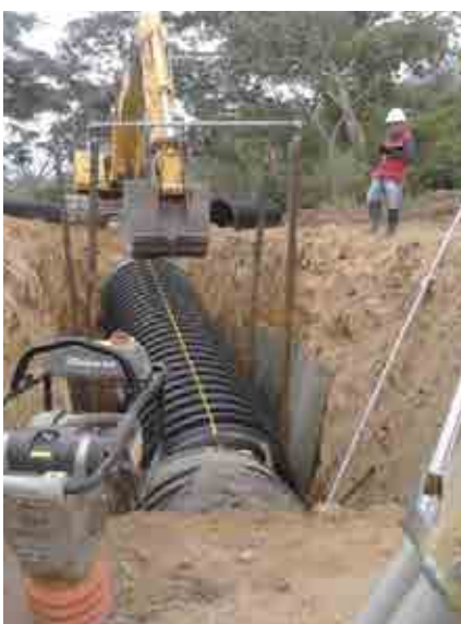
Instalación de Tubería
