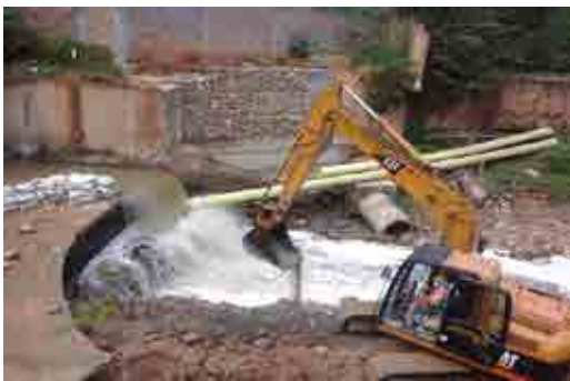
DESVIACIÓN FLUJO DE AGUA EN LA QDA. LA IGLESIA Y LEVANTAMIENTO MURO Y PISO EN GAVIONES.
