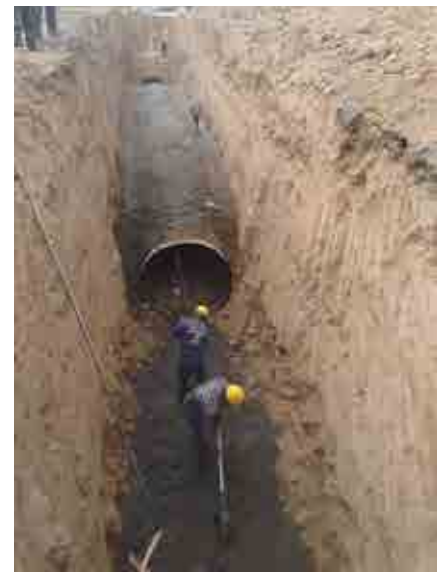
excavación en zanja encamado, acostillada y relleno inicial de la tubería en arena.
