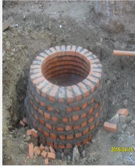
Fase constructiva de pozos de inspección
