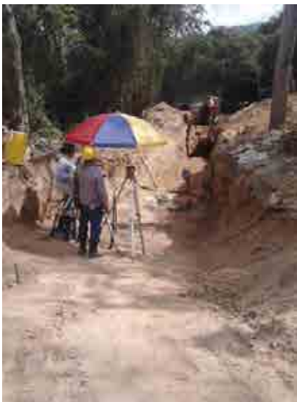
Replanteo, Control y Medición de la obra
