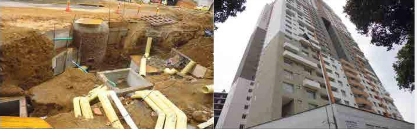
Red de alcantarillado y fachada del edificio
