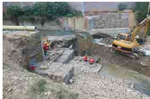
DESVIACIÓN FLUJO DE AGUA EN LA QDA. LA IGLESIA Y LEVANTAMIENTO MURO Y PISO EN GAVIONES.
