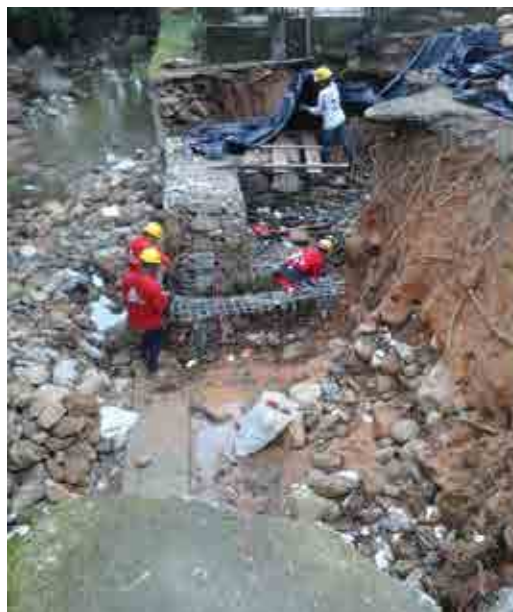
CONSTRUCCION MURO EN GAVIONES
