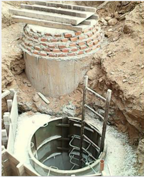
Fase constructiva de pozos de inspección
