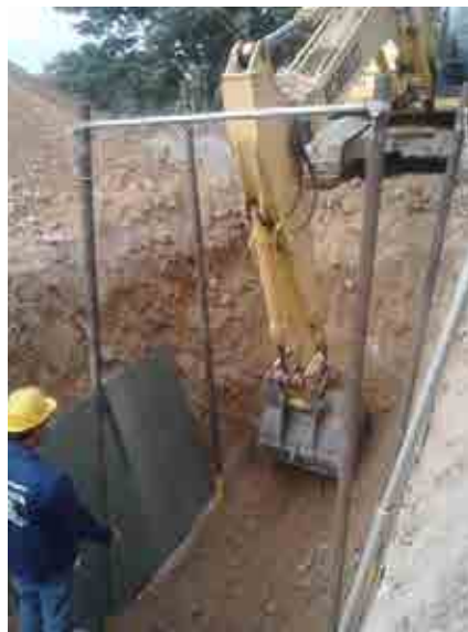
excavación en zanja encamado, acostillada y relleno inicial de la tubería en arena.
