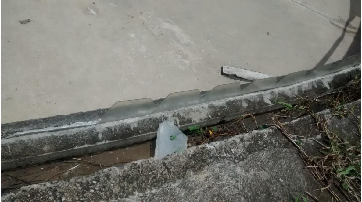
Figura 4: Estado actual de la lámina de vertedero en fibra de vidrio
