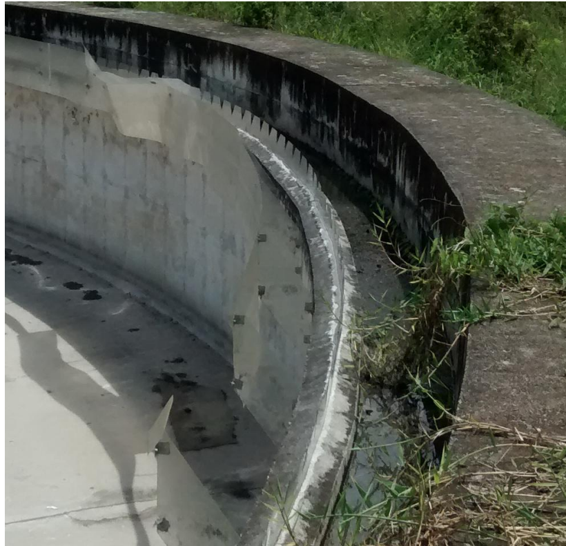
Figura 3: Estado actual de la lámina de vertedero en fibra de vidrio
