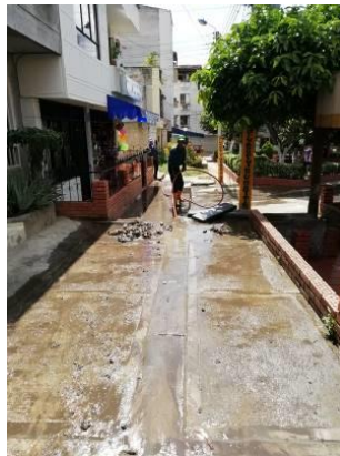
LIMPIEZA CANALETA COAVICONSA
