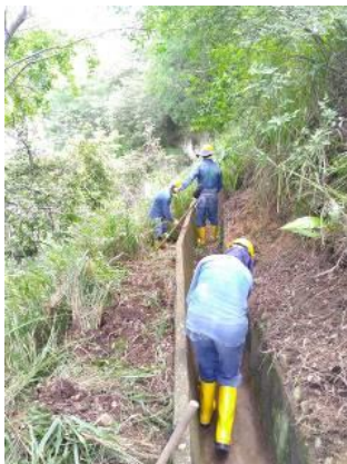
LIMPIEZA CANALETA PORTAL DE CASTILLA
