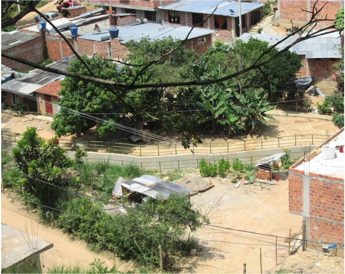
PANORAMICA GENERAL DEL CANAL TERMINADO. ABRIL 30 DE 2014
