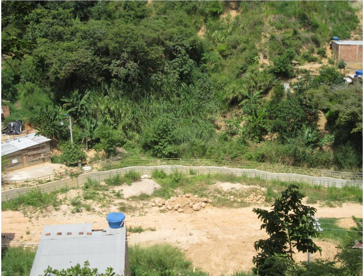
PANORAMICA GENERAL DEL CANAL TERMINADO. ABRIL 30 DE 2014.
