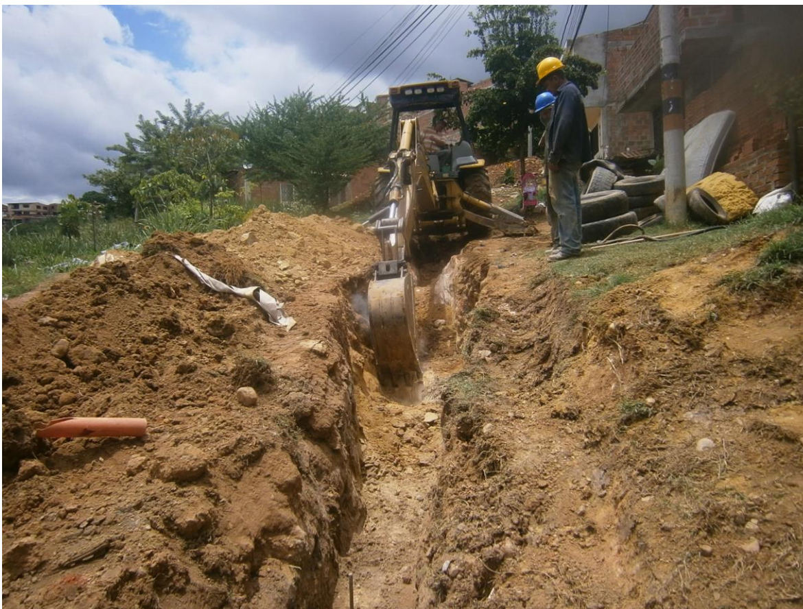
FOTO 1 – EXCAVACIONES – 01 DE SEPTIEMBRE DE 2014
