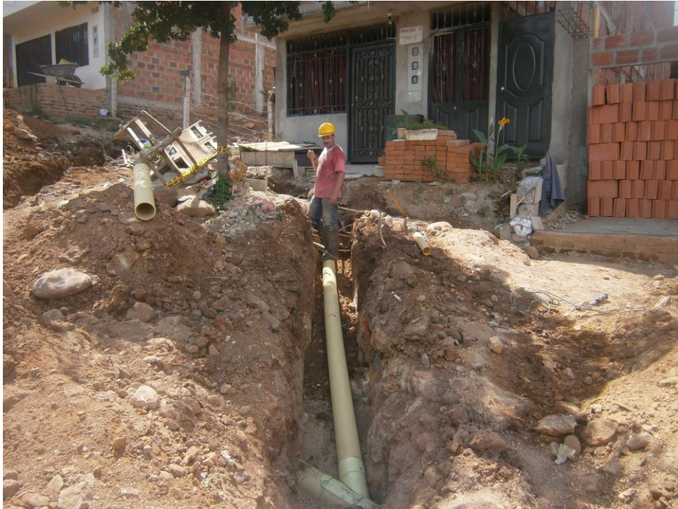
FOTO No. 5 ACOMETIDAS DOMICILIARIAS – SEPTIEMBRE 22 DE 2014
