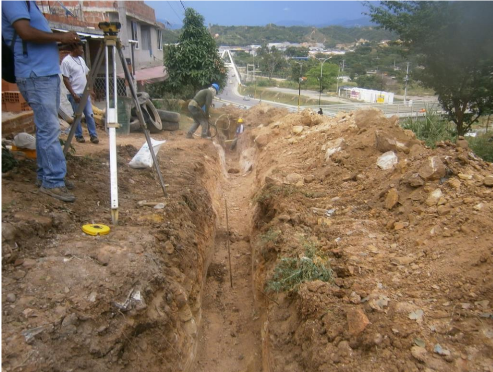
FOTO 2 – EXCAVACIONES – 04 DE SEPTIEMBRE DE 2014
